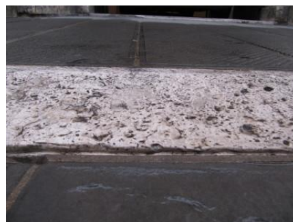
Fig. 3: Particolare del gradino
