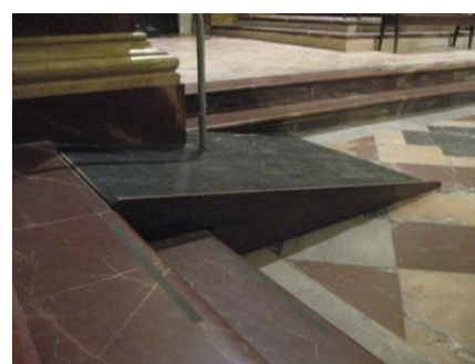
Fig. 4: Rampa di accesso
