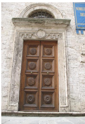
Fig. 5: Ingresso del Nobile Collegio del Cambio con gradino
