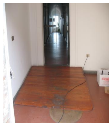
Fig. 4 rampa di legno
